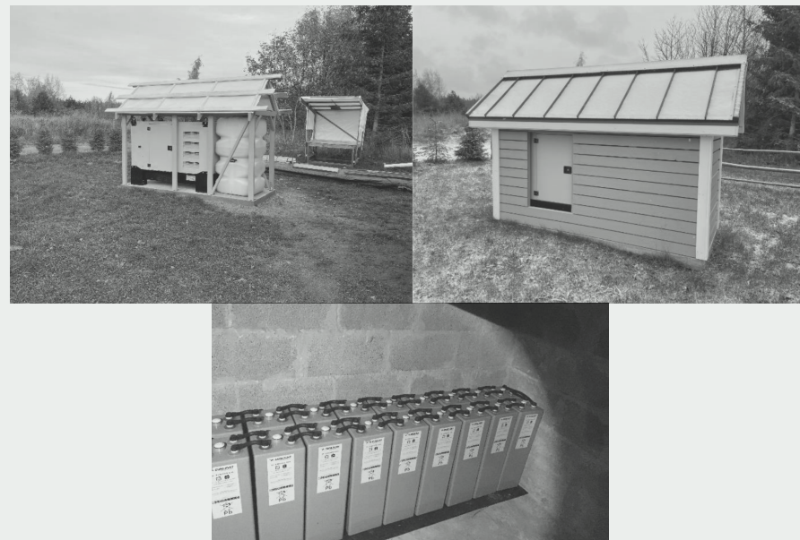
Pildid 4–6. Paigaldatud diisलगeneraator Fogo FDG 12,1 koos lisa mahutiga ja akud. Autor Igor Šramov.
