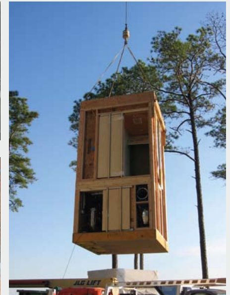
6.5 Kokkupandud vannitoa- ja mehaaniline plokk tõstetakse ehitusplatsil
