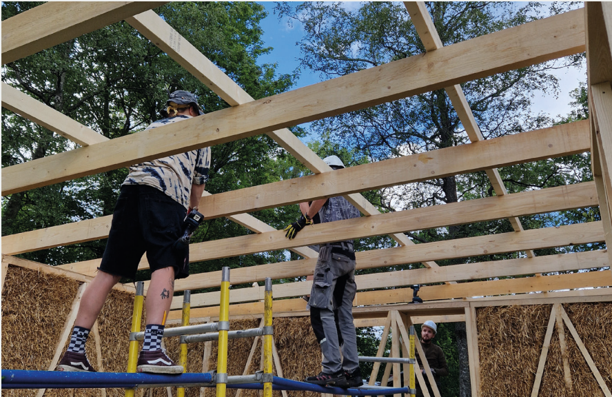
Foto 10. Katusekonstruktsiooni ehitamine.
