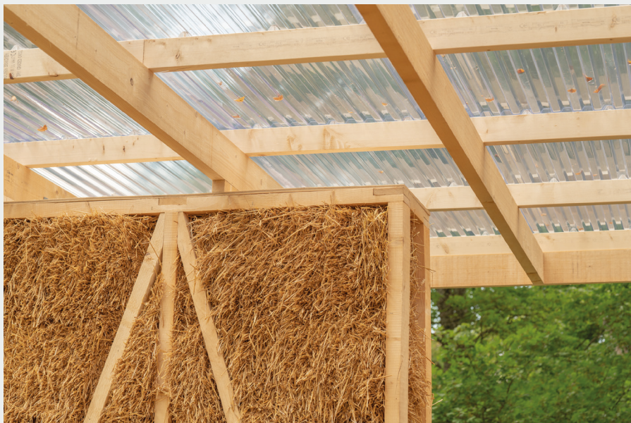
Foto 16. Katuse ja paneeli liitumiskoht.
