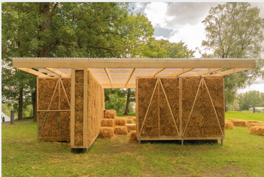
Foto 17. Installatsioon idast vaadatuna.
