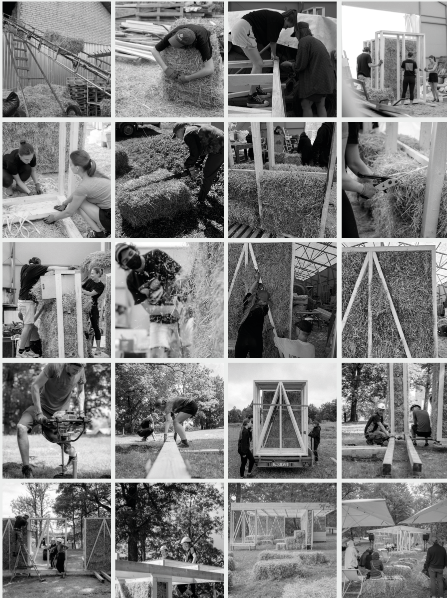
Fotod 22–41. Installatsiooni ehitamise protsess.
