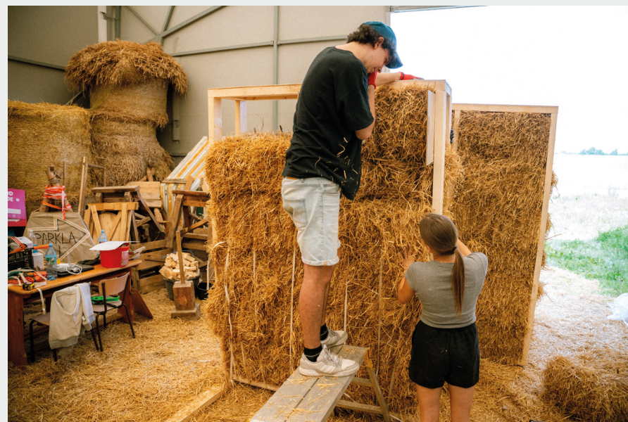
Foto 2. Põhupakkide pressimine karkassi sisse.
