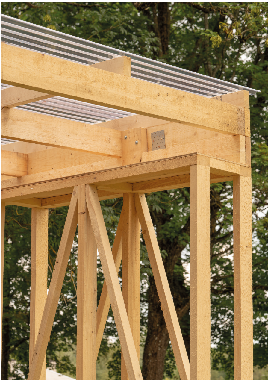
Foto 19. Katuse ja paneeli liitumiskoht.
