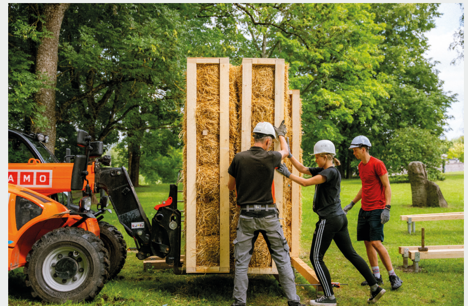
Foto 9. Paneelide paigaldamine vundamendile.
