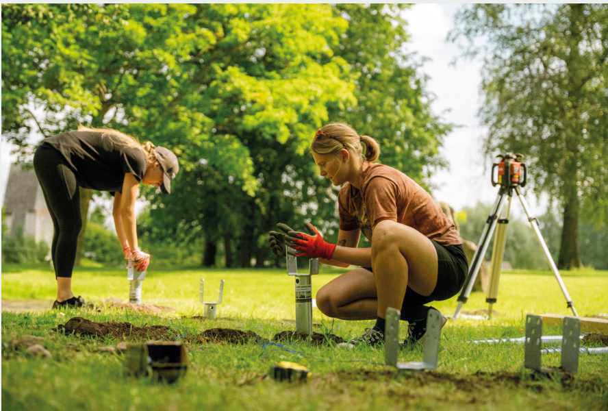
Foto 7. Vundamendivaiade nivelleerimine.
