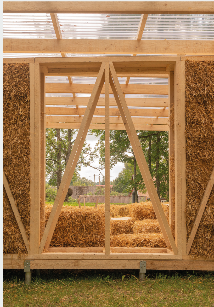
Foto 18. Vade läbi installatsiooni.
